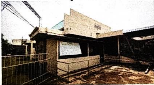
อาคารผู้ป่วยใน ขนาด ๑๐ เตียง
